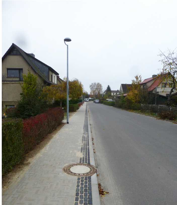
Erst kürzlich wurde der Gehweg in der Eichenstraße saniert
