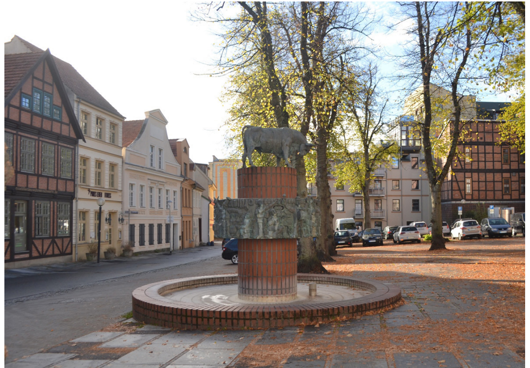
Die Arbeiten zur grundhaften Sanierung und Modernisierung beginnen am 12. November und sollen bis April 2020 abgeschlossen sein.
