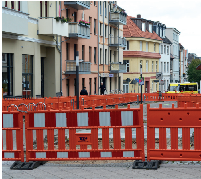
Der grundhafte Ausbau der Straße Großer Moor im Bereich der Fußgängerzone soll rechtzeitig zum Beginn der Freiluftgastonomie im Mai 2018 fertiggestellt sein.
