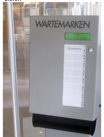
Aufrufanlagen bieten besseren Service im Stadthaus.
