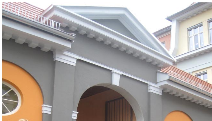
Heinrich-Heine-Schule: Großteil des Daches und der Fassade erstrahlen in neuem Glanz.
