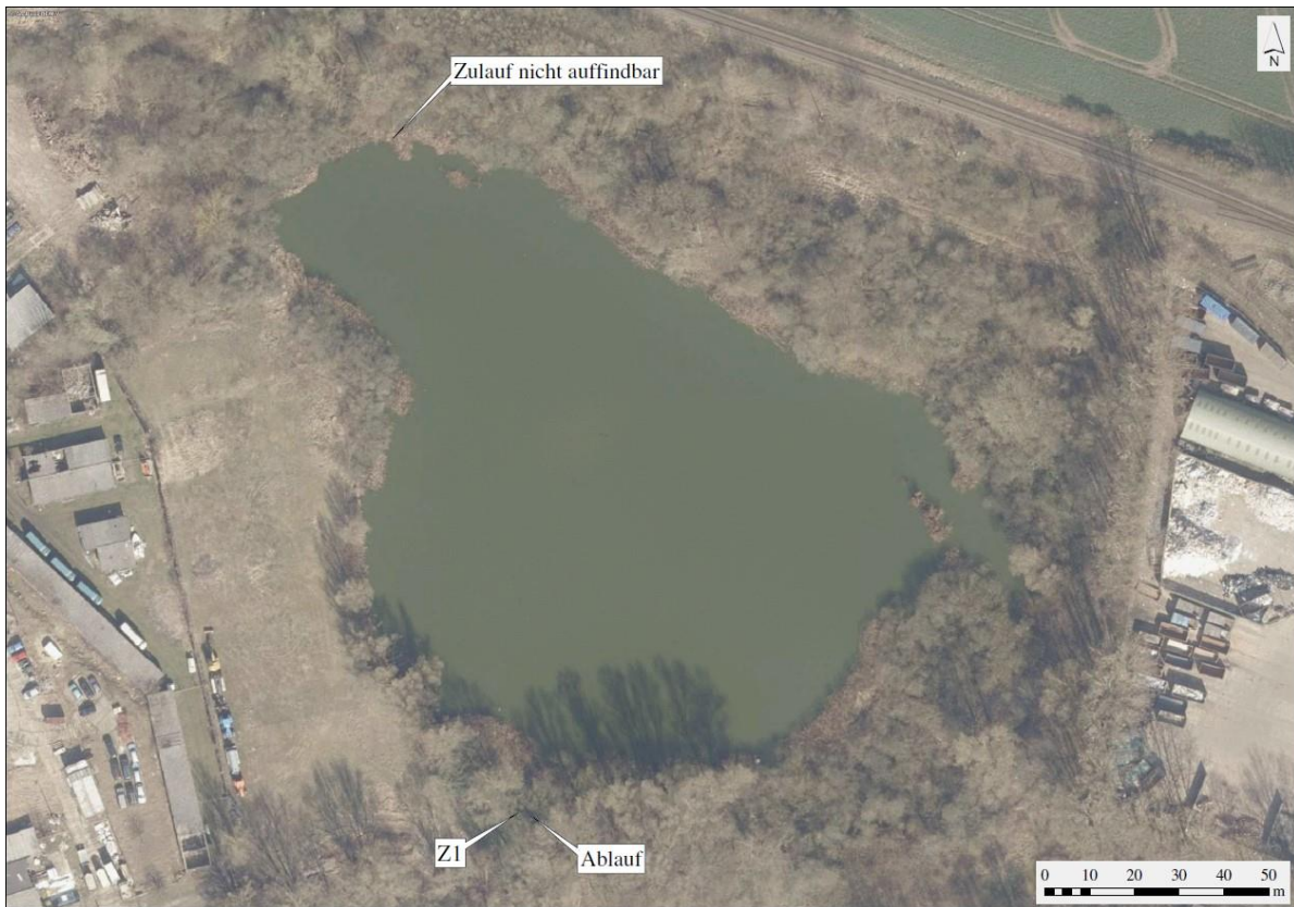
Abb.3.4-5: Lage der oberirdischen Zuläufe und des Ablaufs am Ziegeleiteich (LUNG M-V 2022a)
