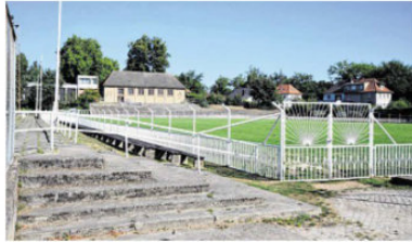
Die Sportanlage auf der Paulshöhe soll abgerissen werden und Platz schaffen für Bebauung. Die Hallen müssen bleiben. FOTO: KAWI
