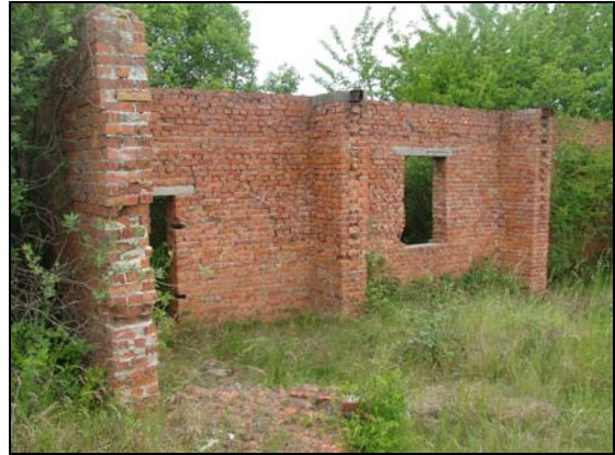
Abb. 7: Gebäuderuine ohne Relevanz für Fledermäuse
